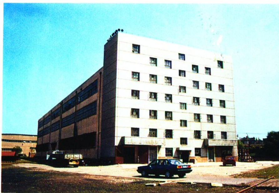
沈阳材料厂高层仓库
