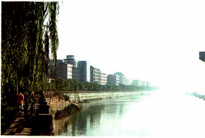
铜河西路防洪堤
