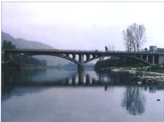
新建公路桥——汤山镇荆竹大桥。
