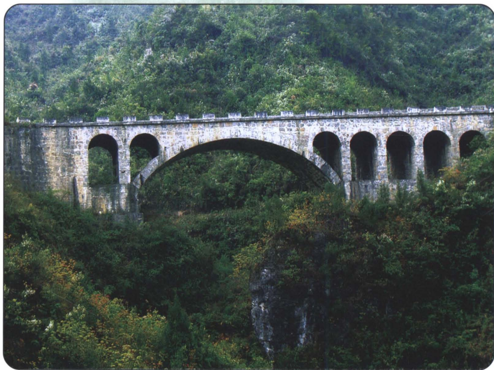
新建公路桥——石镇线上豹虎湾大桥。
