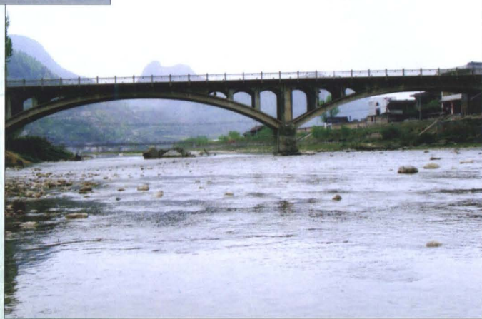
新建公路桥——中坝镇大桥。
