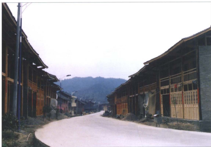
石镇公路过境坪山仡佬族侗族乡硬化路面。
