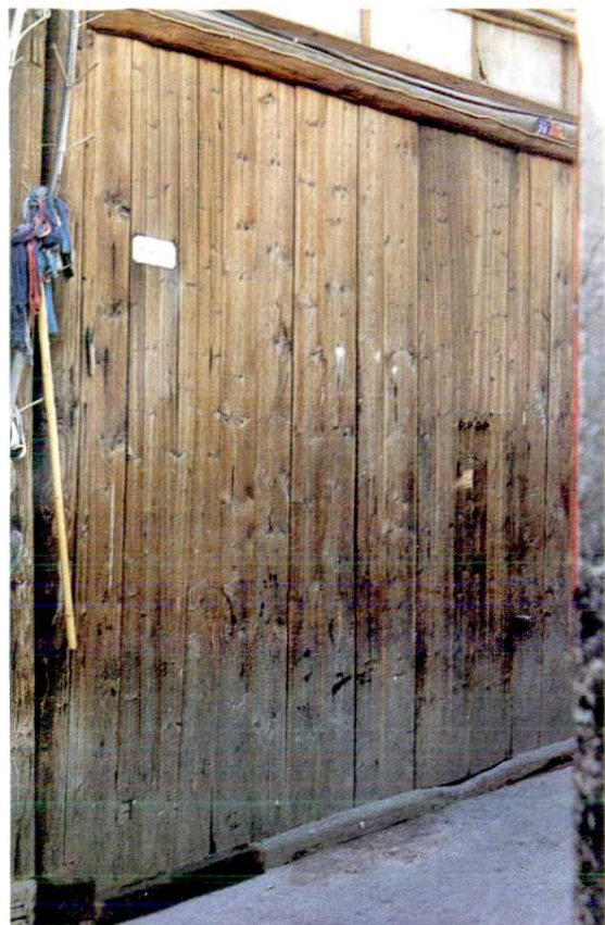
(1931-1932.1)河口苏区秘密地下交通站旧址
