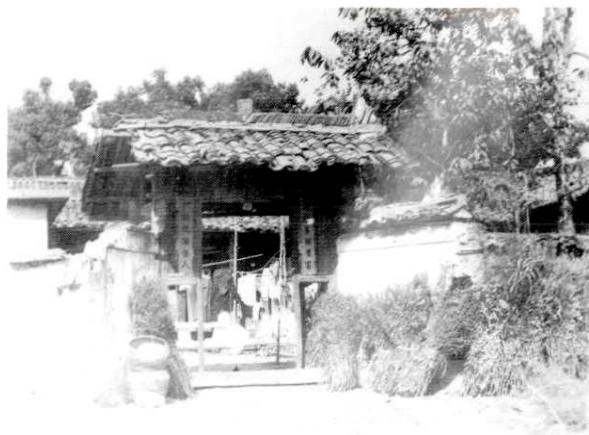
(1944-1945.8)铅山电信局旧址
