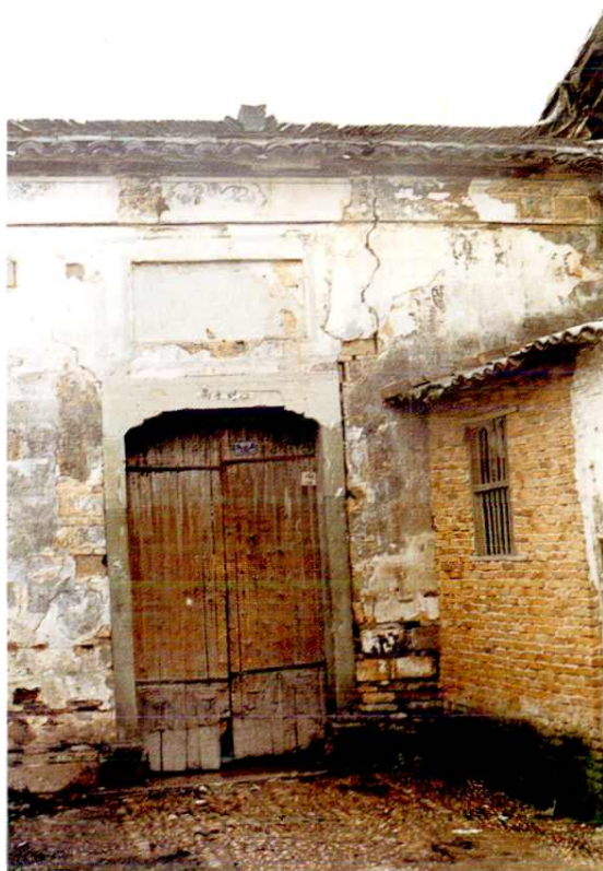
(1946.9-1951.9)铅山电信营业处旧址
