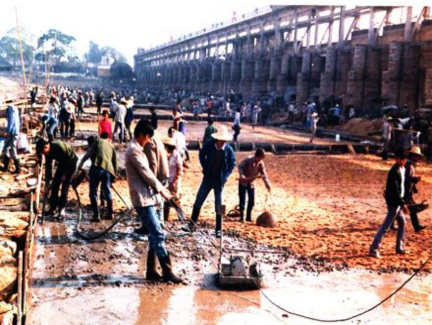
◀ 1989年莲阳桥闸加固工程上游连接段铺盖浇筑混凝土施工现场面。
