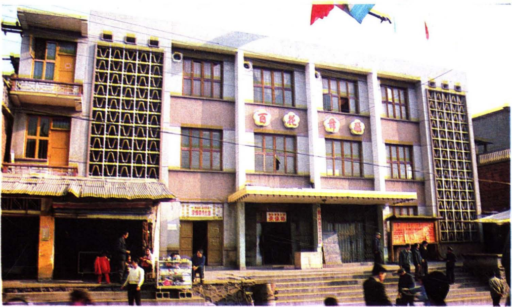
独山县总工会大楼外貌
