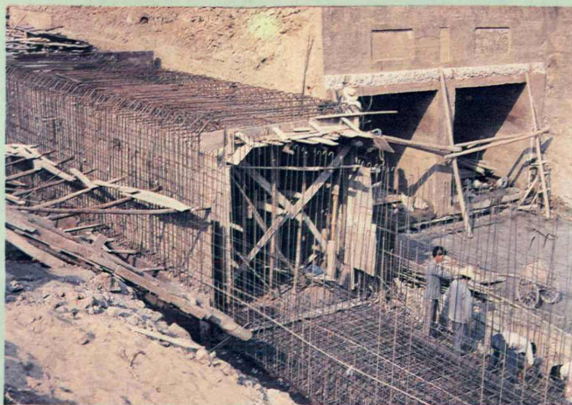
金安围扩建新 孖窠施工现场
