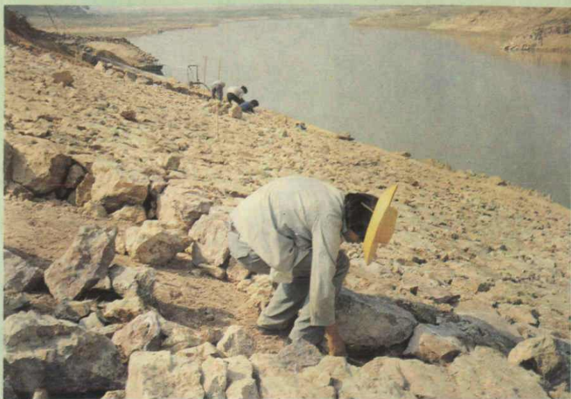
莲塘围加固工程 迎流顶冲砌石护岸
