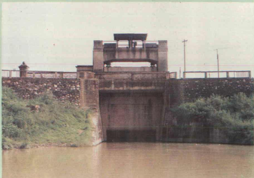
联安围宋隆水闸 (1927年建成) ▶
