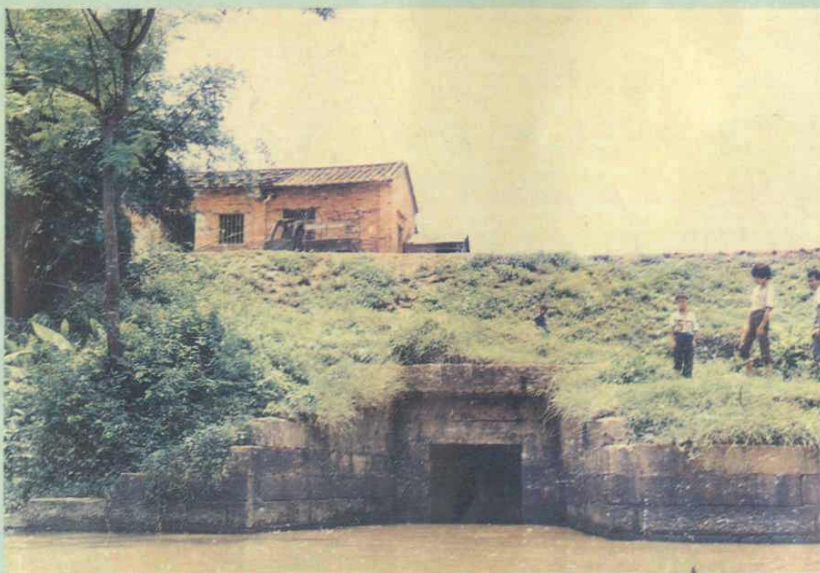
原长赤围北窰 (明代建) 建筑 材料为料石盖 板方涵
