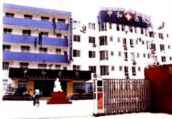
中和卫生院门诊大楼
