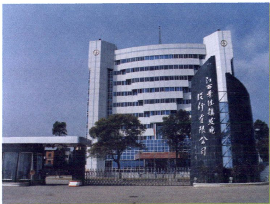
雄伟壮观的景德镇发电厂综合办公楼
