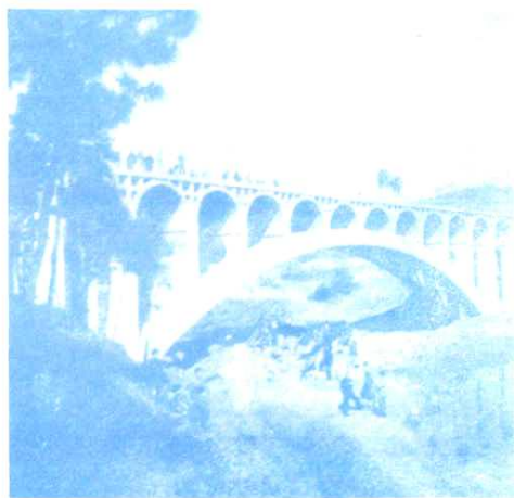
三溪口水库引水渡槽之一： 青狮公社境内的稻子渡槽。
