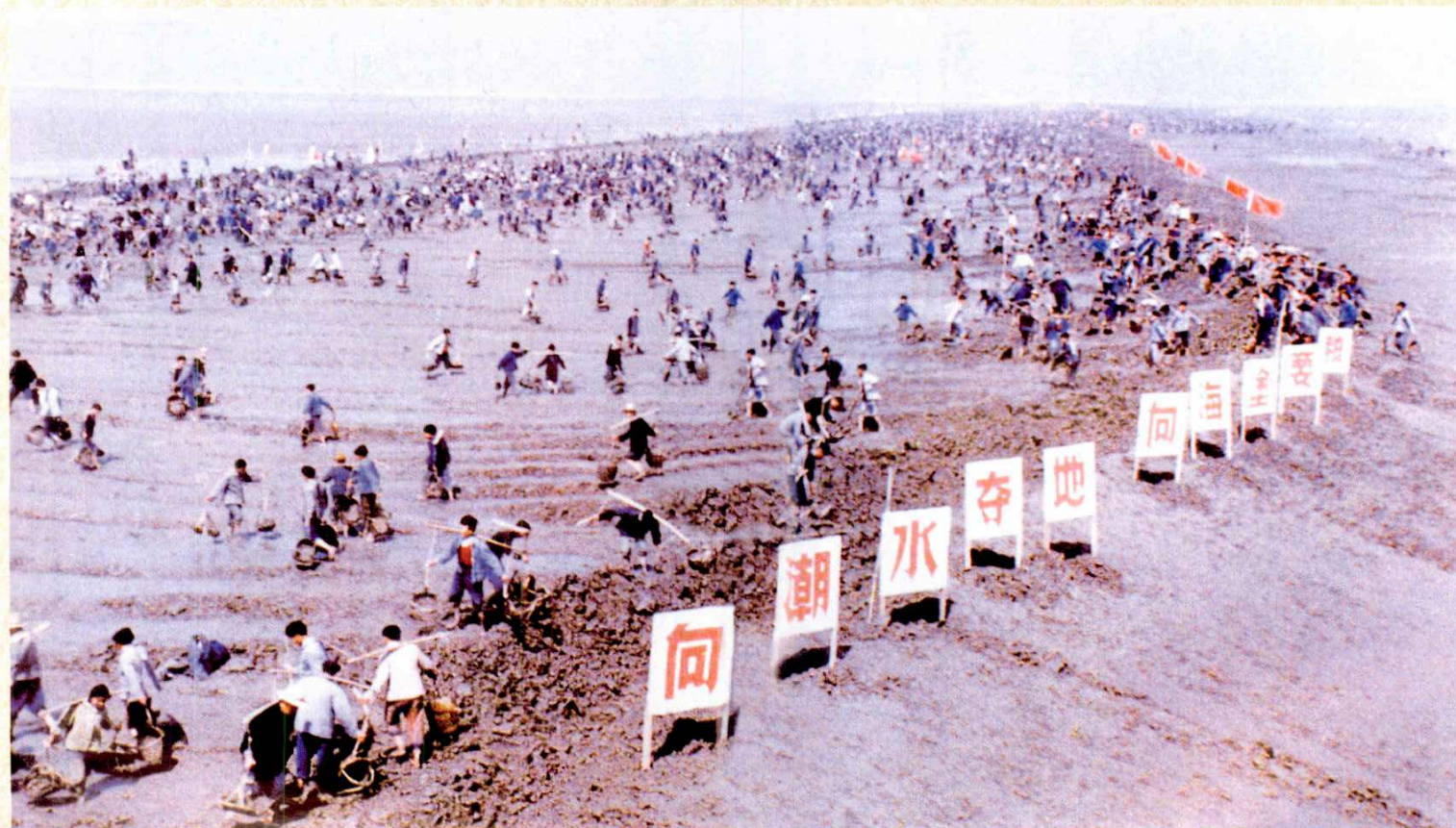
萧山围垦现场
