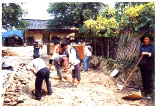
农民正在修建联户路
