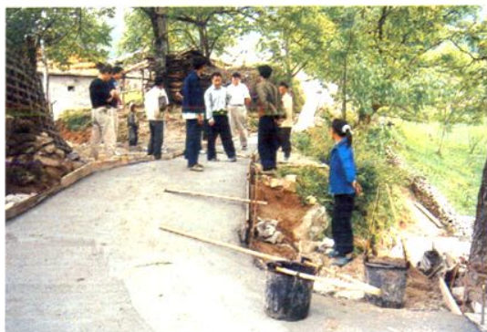
农民投工投劳修建的联户路
