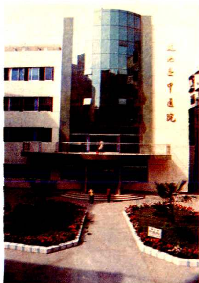
▲ 县中医院门诊大楼
