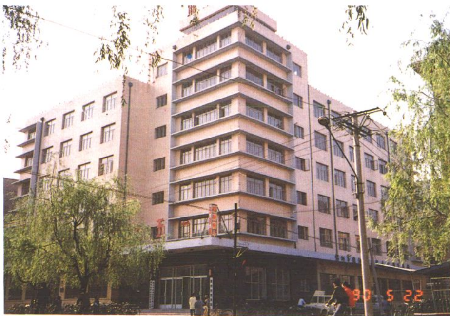
锦州市粮食局办公大楼
