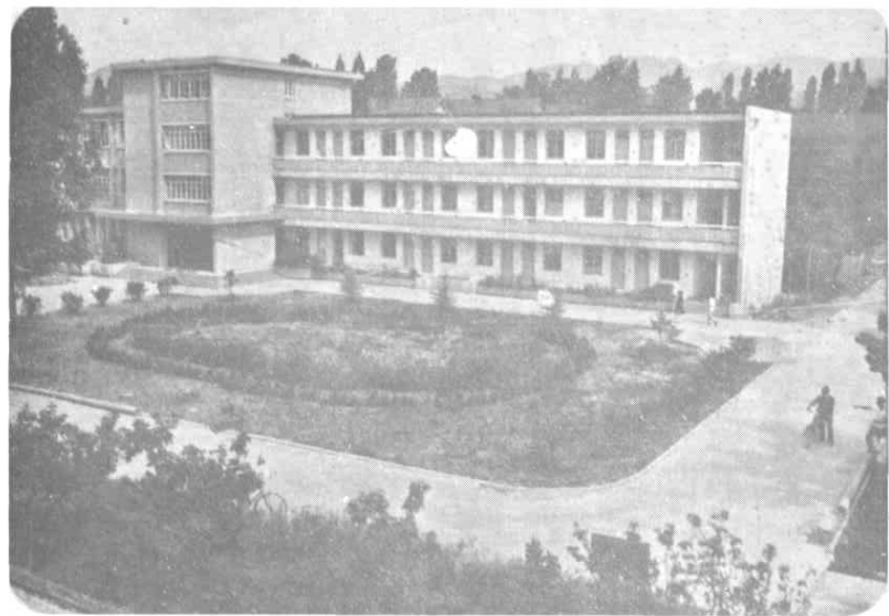
绩中教学大楼
