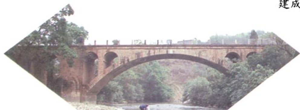
▲大岔河桥 (1972 年建成)
