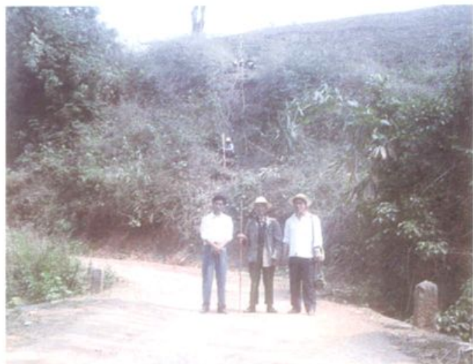
◀ 军弄公路改线测量现场及 测量队伍(1996 年)
