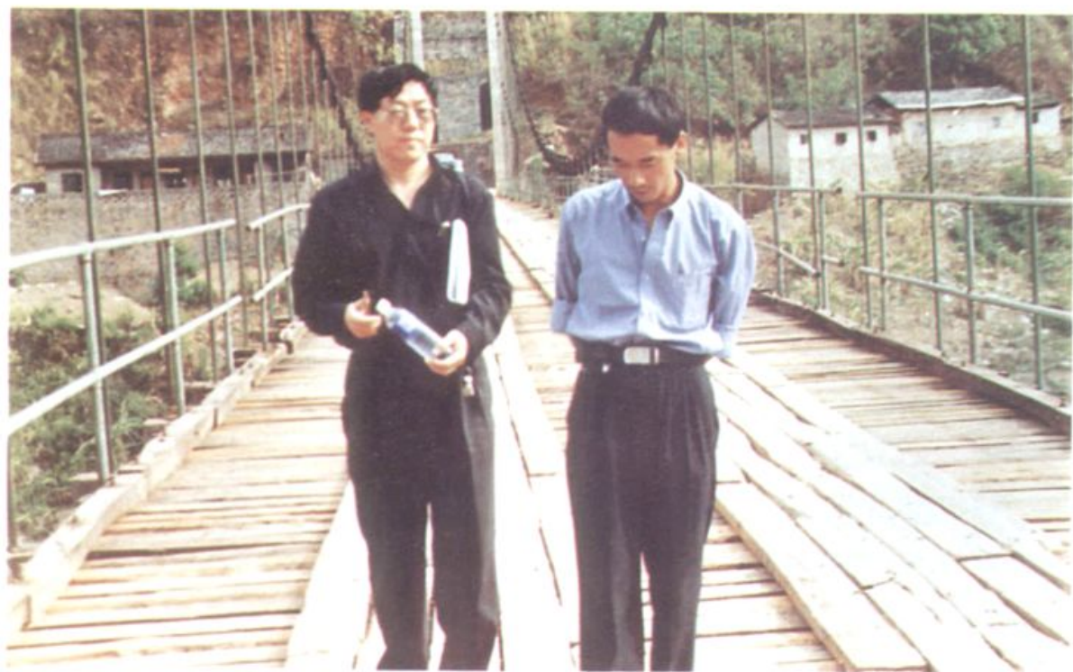
▲省公路局副局长金加福(左)到镇康视察龙镇大桥病害,由政府副县长熊家周(右)陪同
