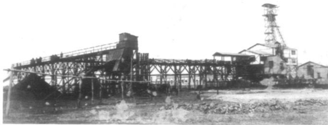
1913年，中兴公司第一大井（南井）建成投产。
