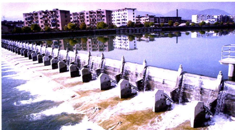
扬之河自动翻板闸
