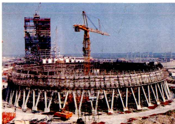
19 安徽电建二公司采用爬模工艺建造平圩发电厂 6500 平方米冷却水塔
