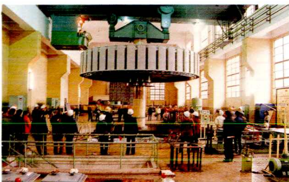
34 陈村水电站水轮发电机吊转子
