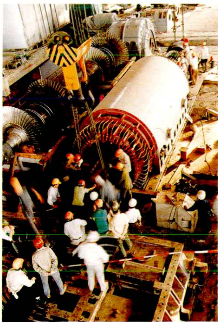
16 安徽电建一公司职工在洛河发电厂 工地为30万千瓦发电机穿转子
