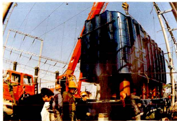
47 220千伏淮南西山变电所主变压器吊罩
