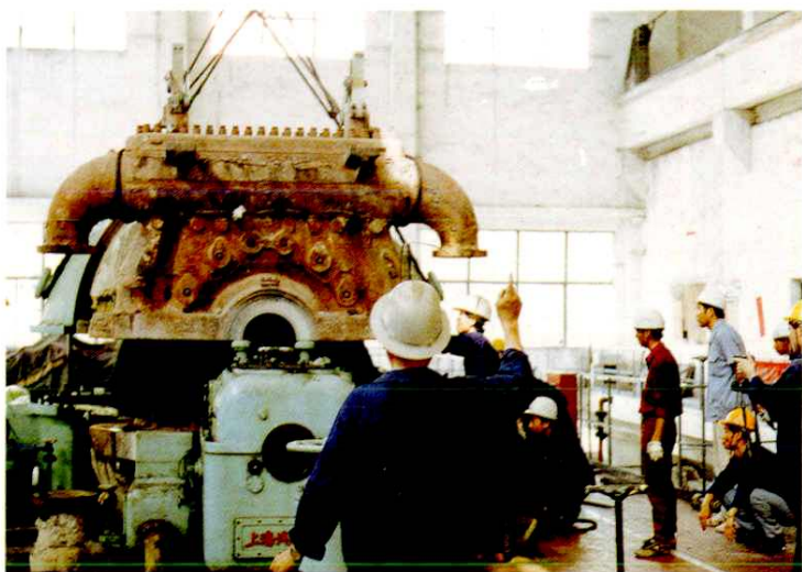
13 贵池发电厂汽轮机检修
