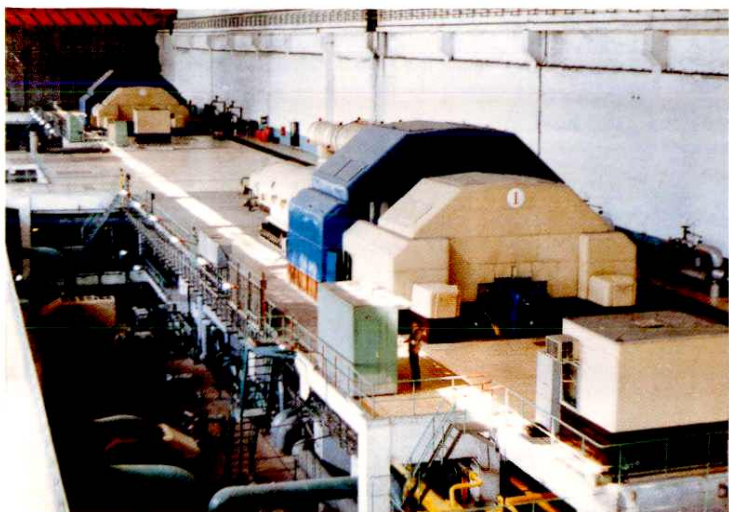
17 洛河发电厂第一期工程 2 台 30 万千瓦发电机组
