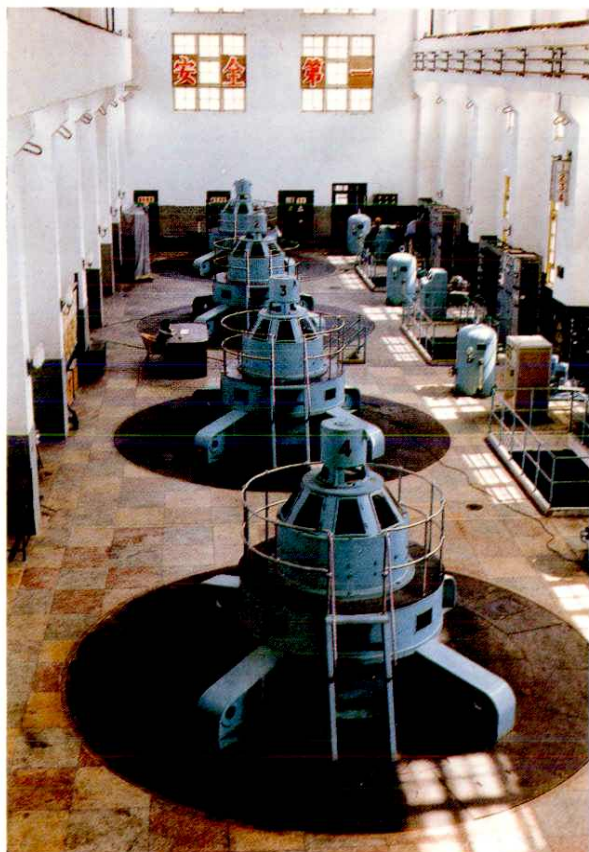
37 花凉亭水电站4台1万千瓦发电机
