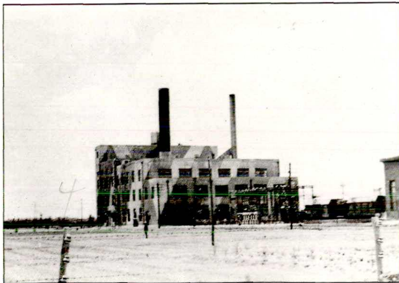
8 民国三十二年(1943年)淮南下 窑(田家庵)第一发电所(厂房 按2台6000千瓦建造, 实装1台 2000千瓦机组)
