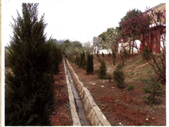
农村排水设施
