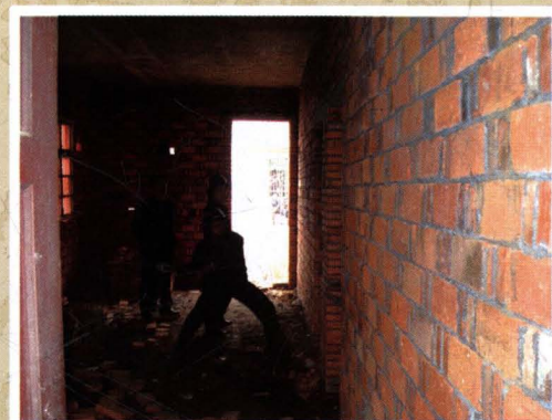
拆除违章建筑
