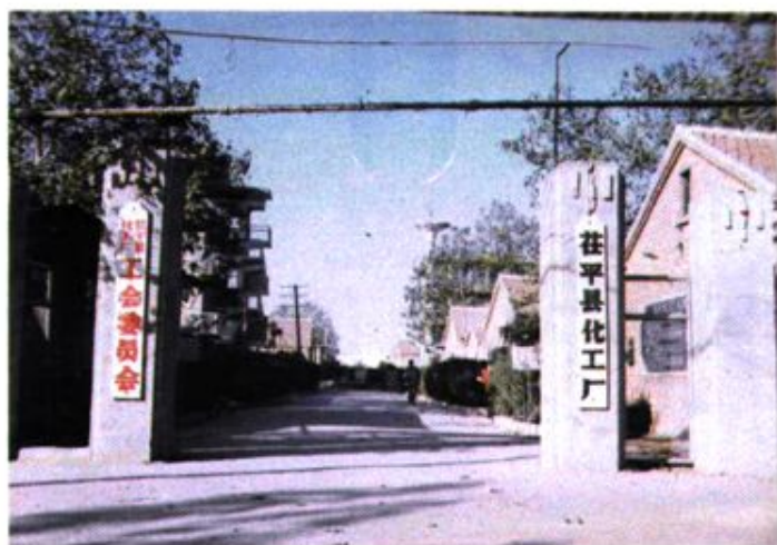
化工厂厂区一角
