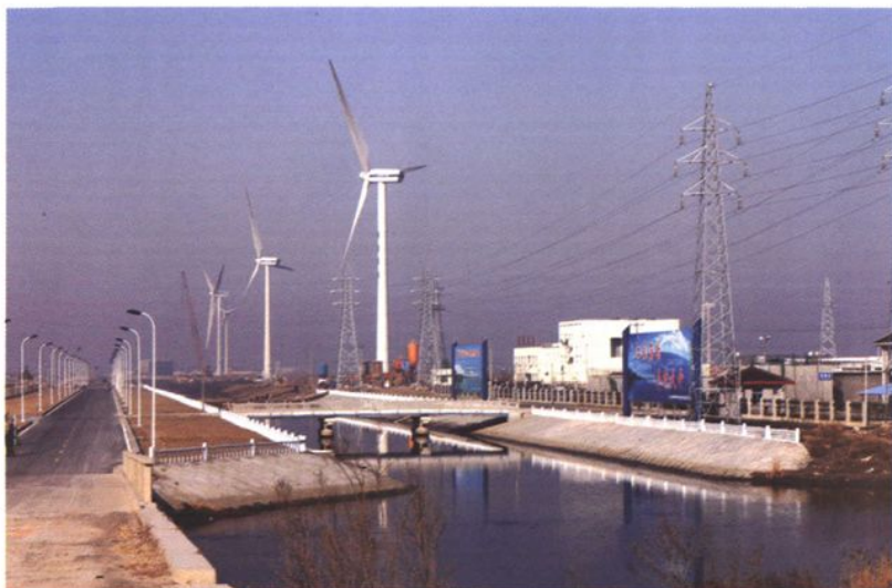
建设中的如东风电 场 (2005年摄)
