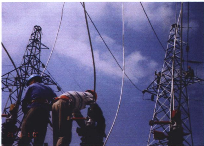
2002年5月，220千伏 线路施工场景
