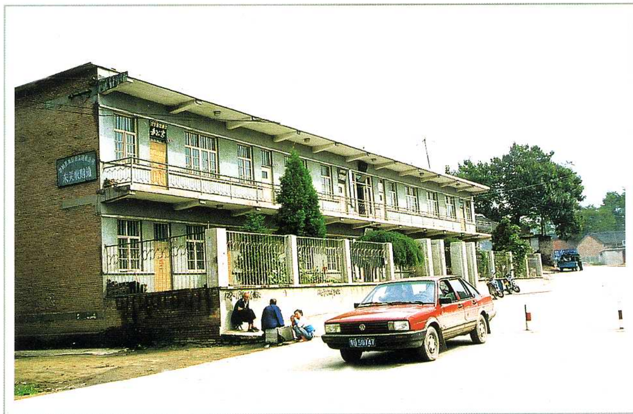
东关村委会办公楼
