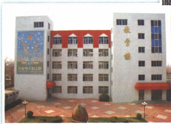
▼ 龙口三中新建的教学楼
