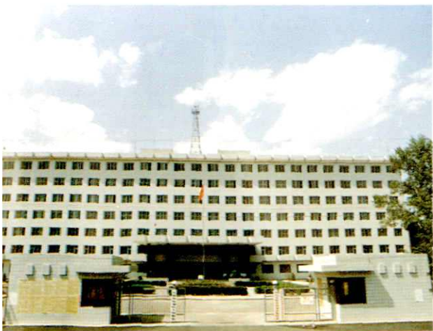
区委、区政府办公楼
