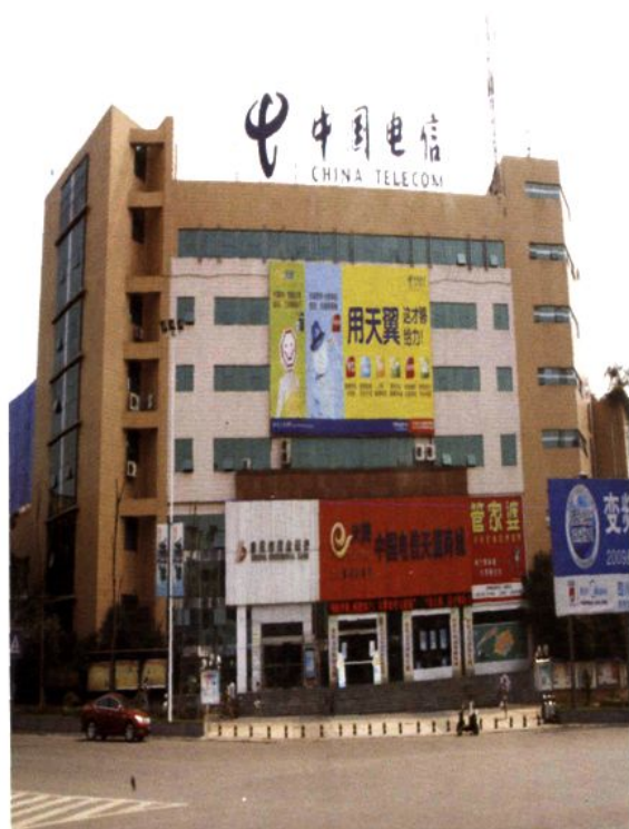
电信办公大楼
