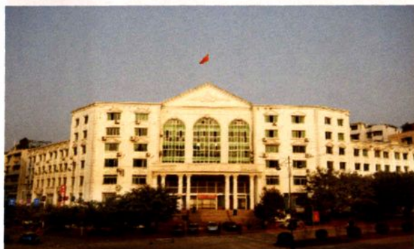
建设局办公楼
