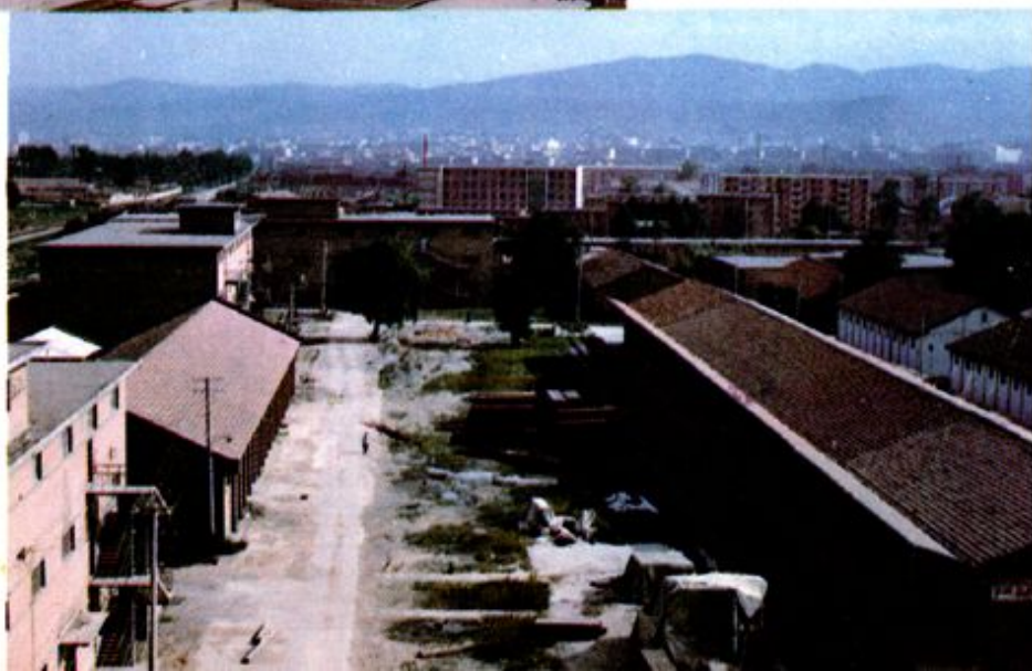
储运站库区一角
