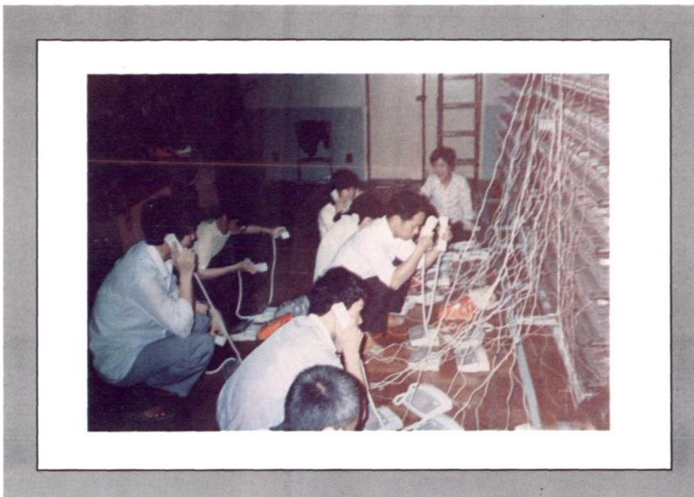
▲ 1990年5月4日，921纵横制自动电话开通前在进行接通率测试，
