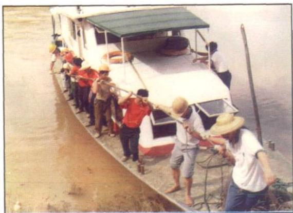
◀ 抗洪救灾，机线员在抢修被洪水冲毁的过河电缆
