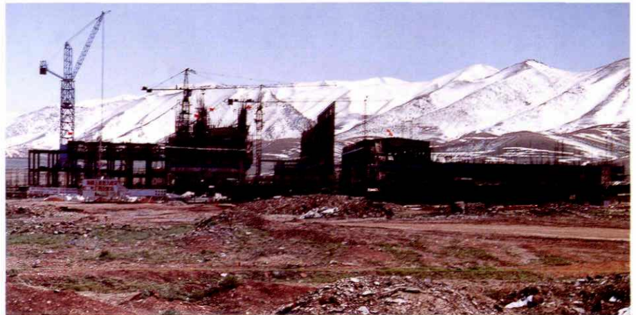
建设中的红雁池 第二电厂
