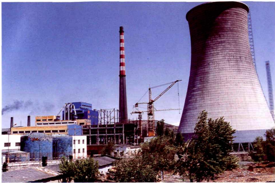
菁湖梁电厂技术 改造工程
