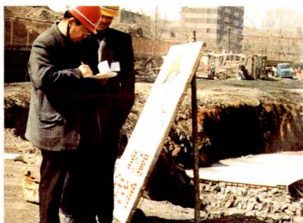
监理人员进入施工现场
