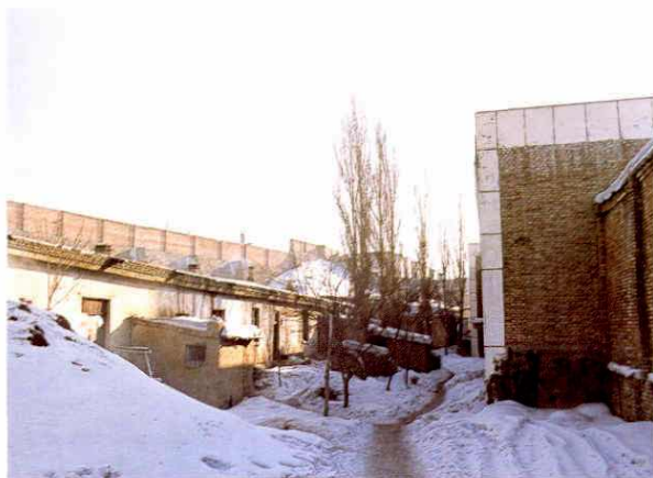
家属楼平房原址
