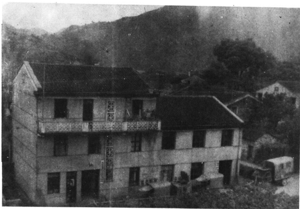
革命老区岩坦供电管理所全景
