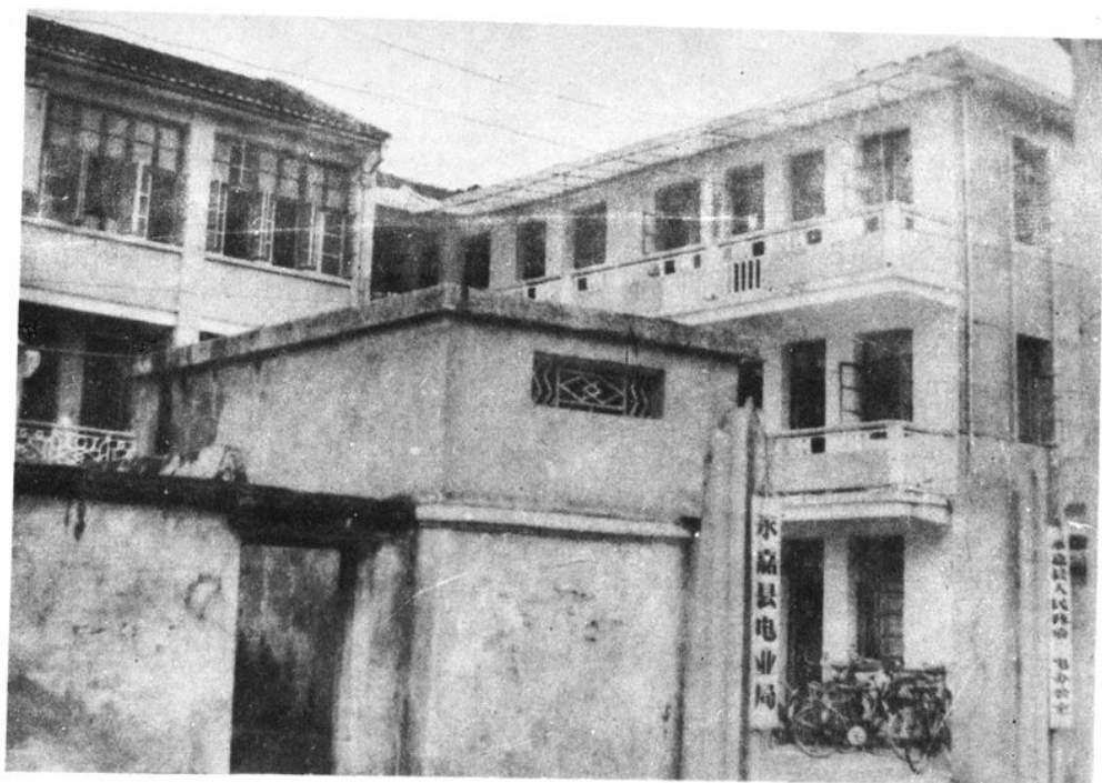
永嘉电业局临时办公楼
