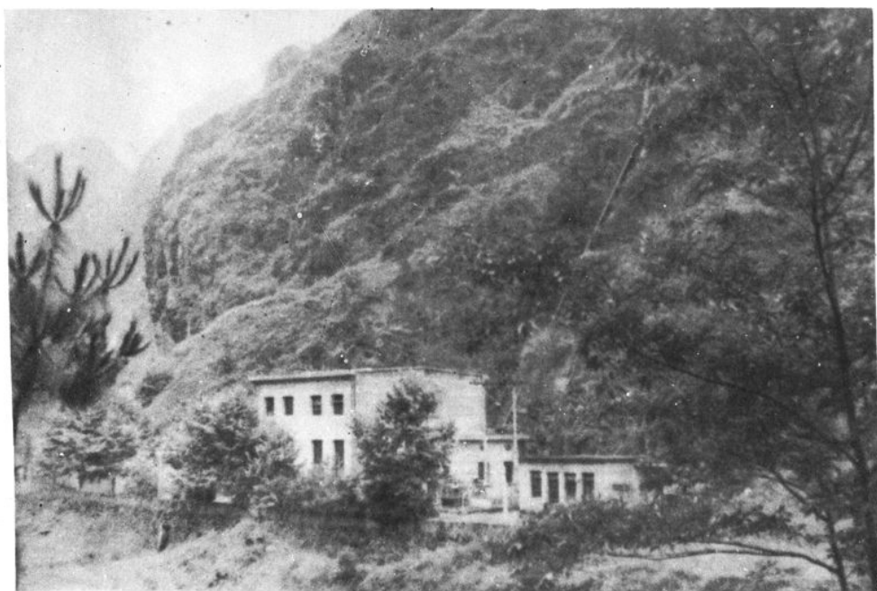
山溪头水电站一角
