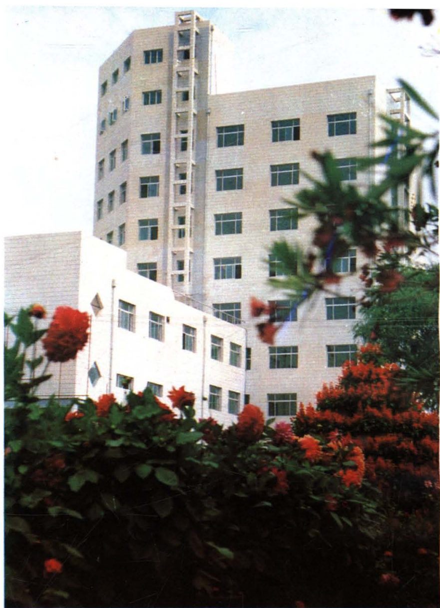
图为现已使用的连城铝厂新办公楼
