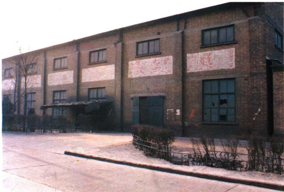
图为旧机修厂房外景
