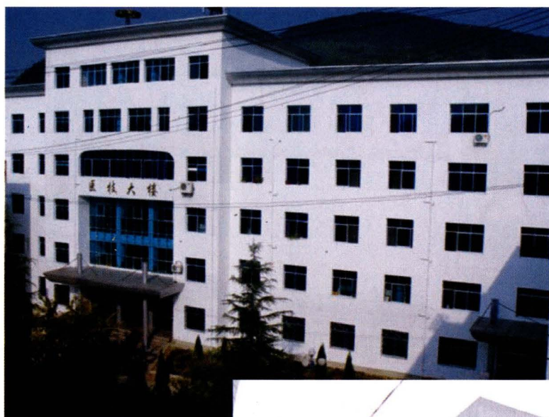
◀ 德江县人民医院 医技大楼(2005建)
