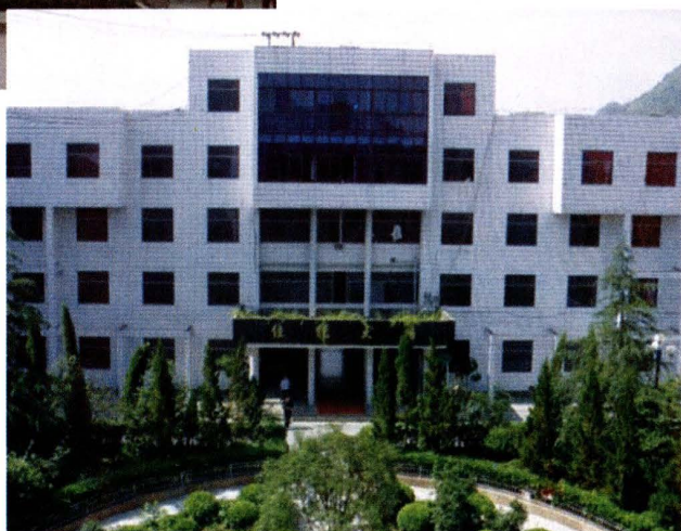
◄ 德江县人民医院 门诊大楼 (1992年建)
