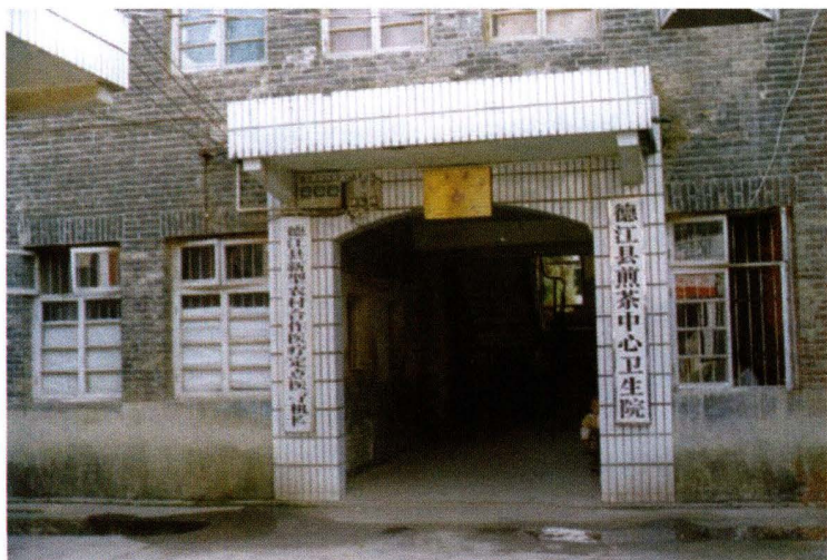
▶ 煎茶中心卫生院 门诊楼 (1974年建)
