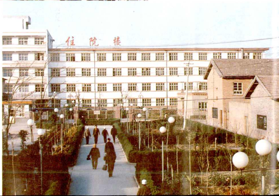
富平县医院住院楼
