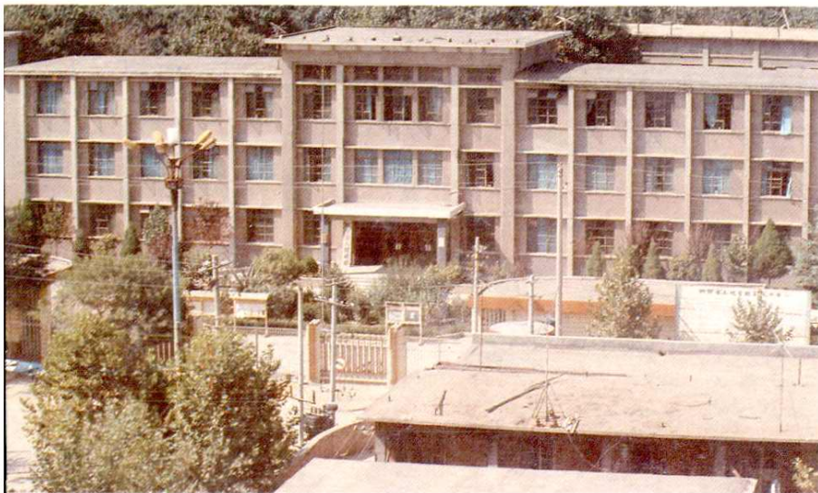
富平县人民政府办公大楼
