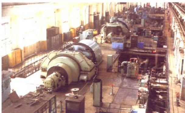
太原第一热电厂汽轮发电机组
