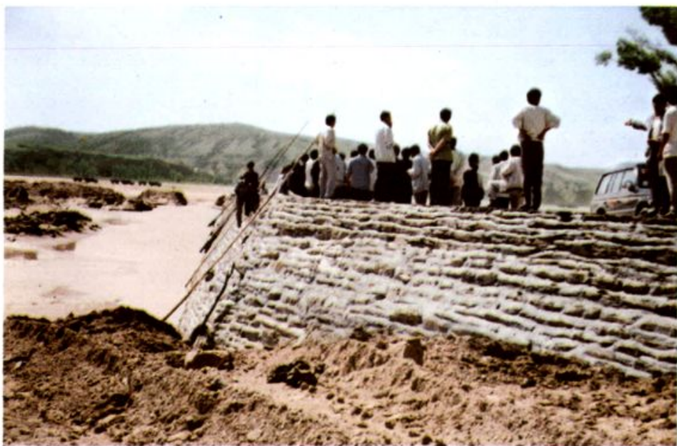
柳塔村防洪工程
