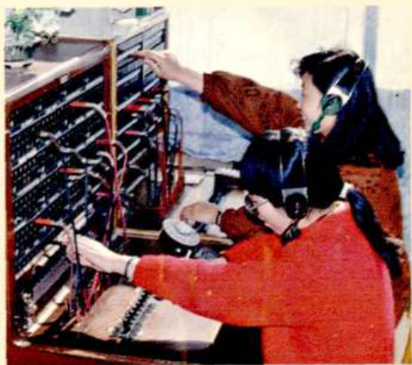
80 年代,鲁垛邮电 支局磁石交换机房
