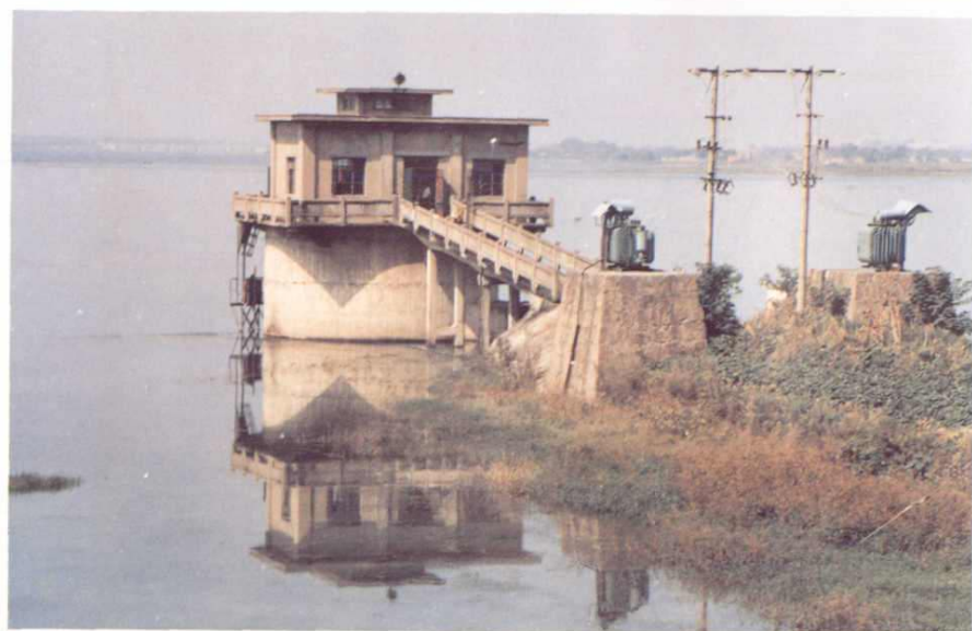
自来水厂泵站
