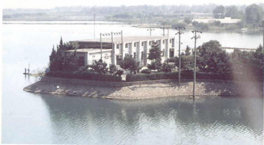
合肥发电厂 冷却水取水口泵房
