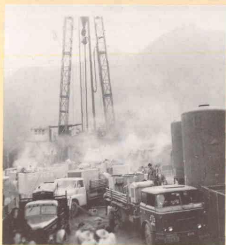
▲ 正在进行压裂酸化作业
