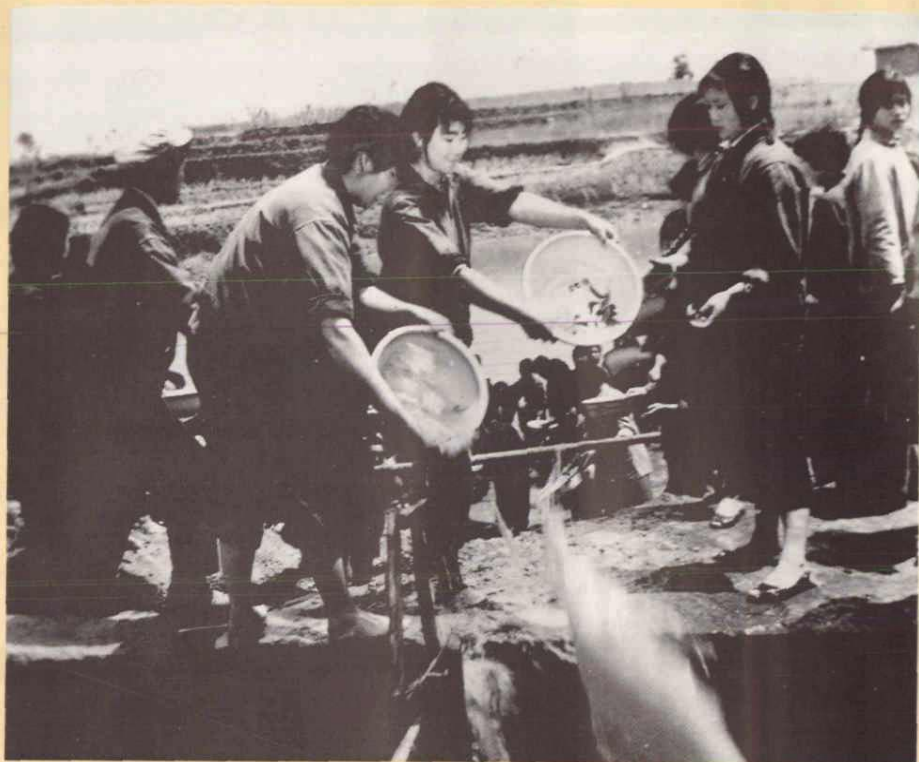
▲ 钻井工人抗旱端水打井
