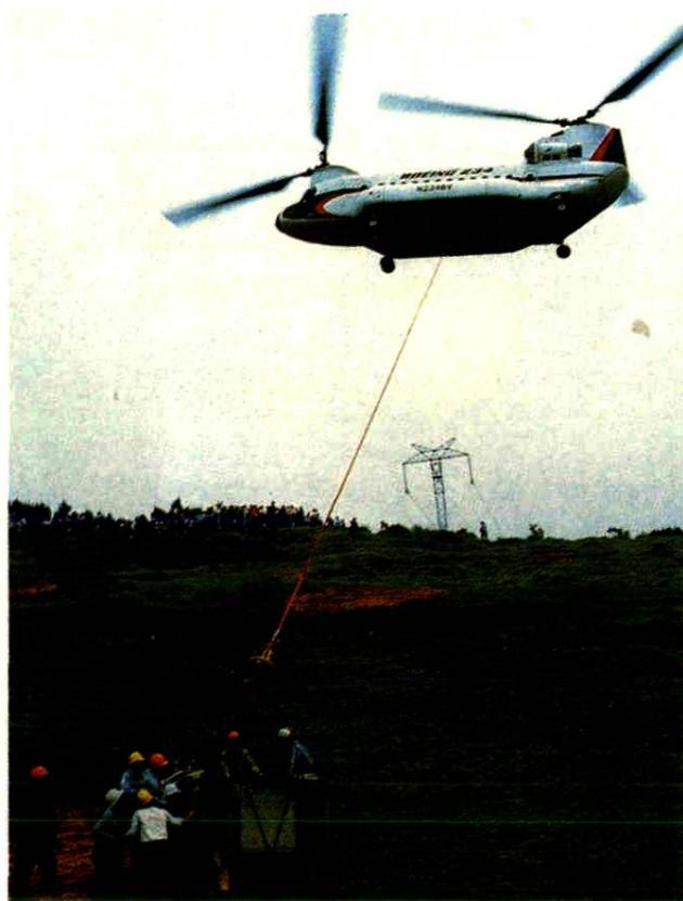
26 吉林送变电工程公司在500千伏葛上线吉阳长江大跨越工程中应用直升飞机放线
