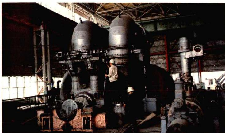
23 沈海热电厂1号机中、低压缸安装
