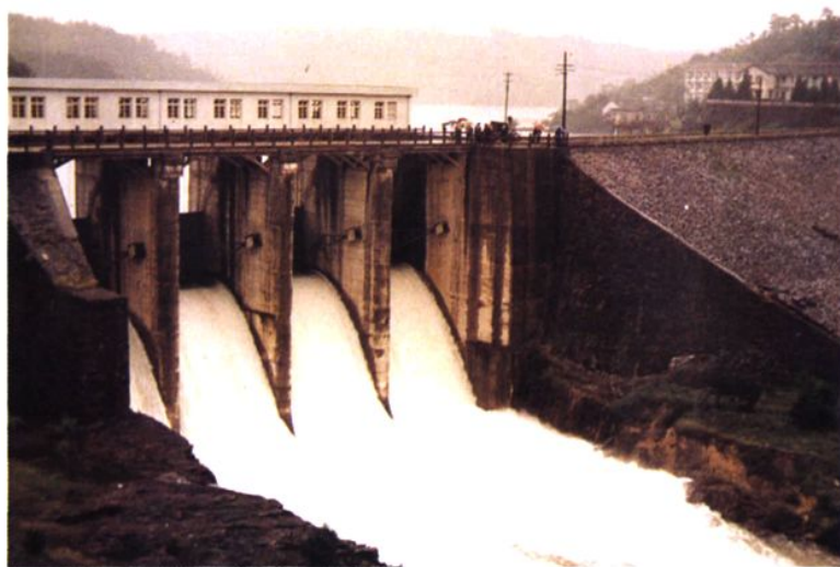
五丈岩水库泄洪道
