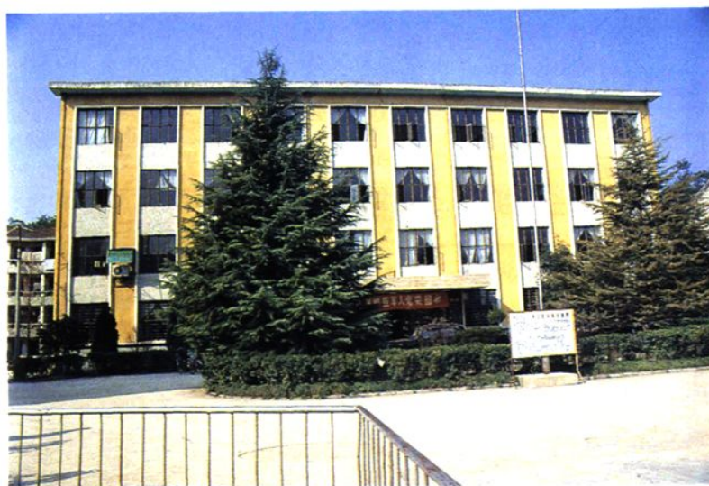
磐安县人民政府办公楼
