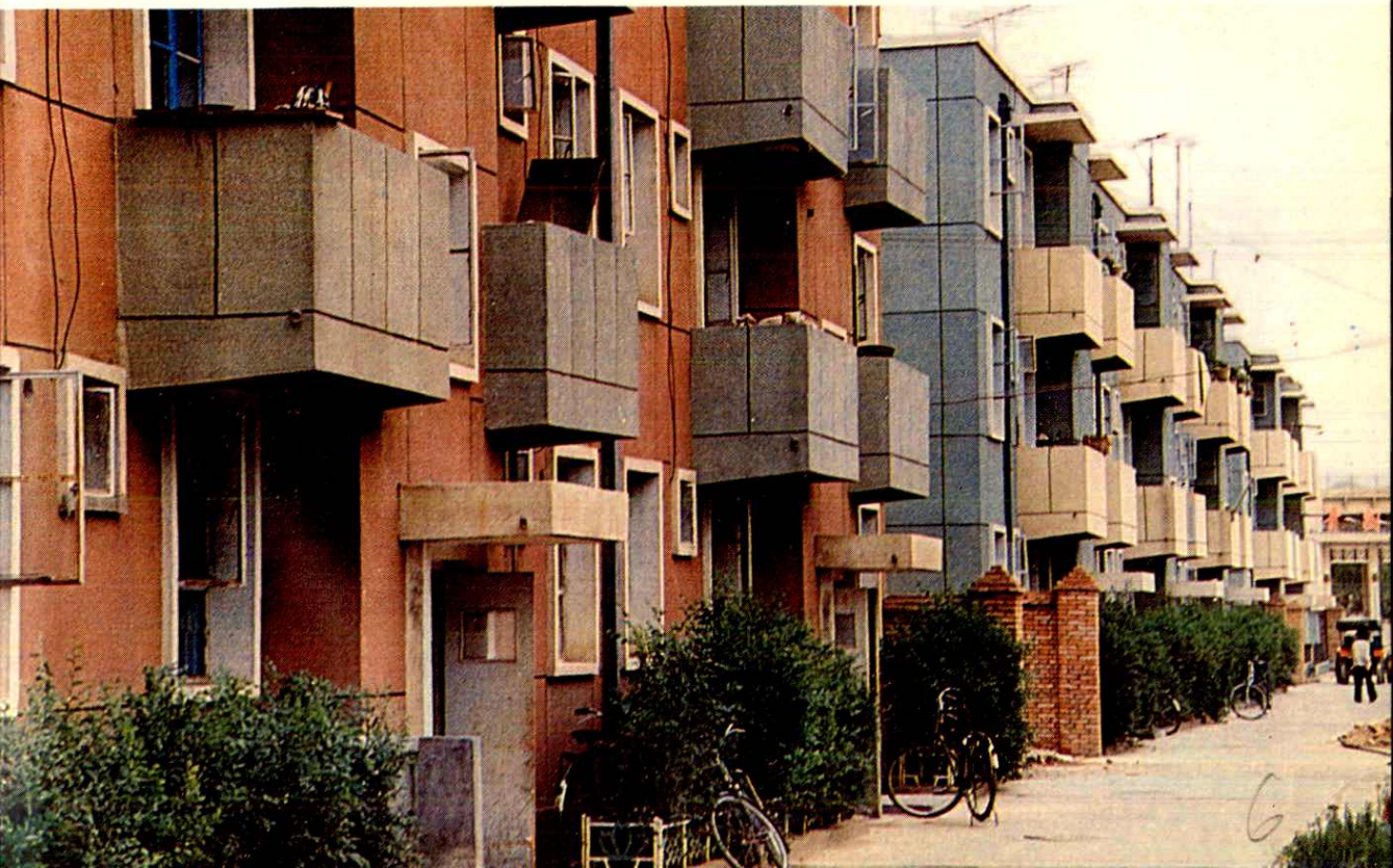
厂家属住宅楼
