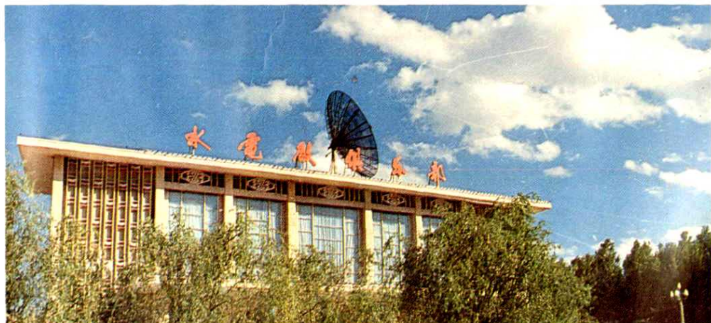
水电厂俱乐部
