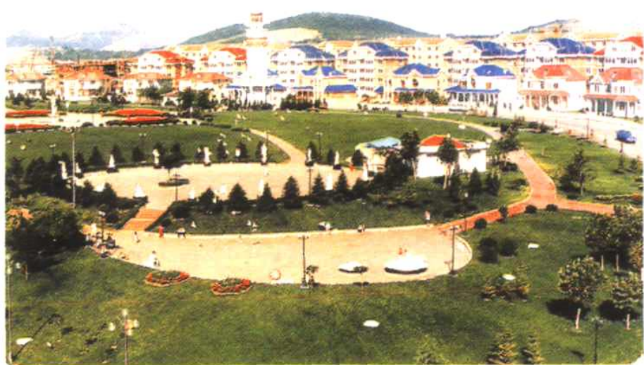
新建的泡崖居民新区
