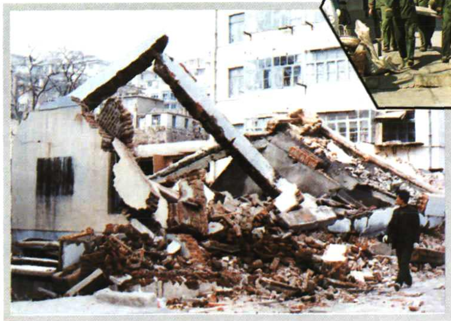
拆除违章建筑18.5万处，还绿于民，让居民走出家门进花园。
