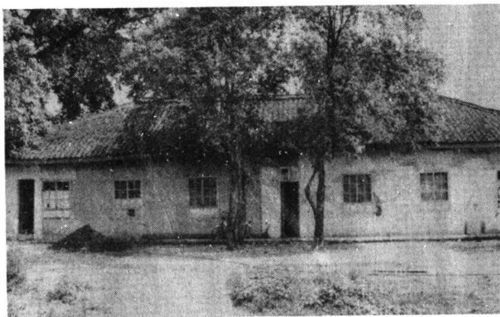
卫生署 峨眉公路 卫生站
