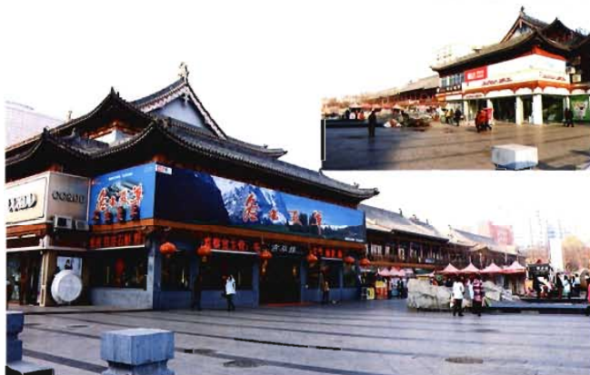
长治城隍庙景区改造工程
