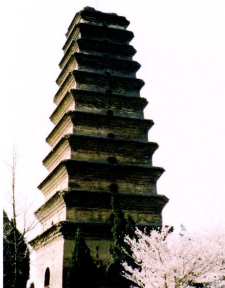
唐代所建善导大师供养塔
