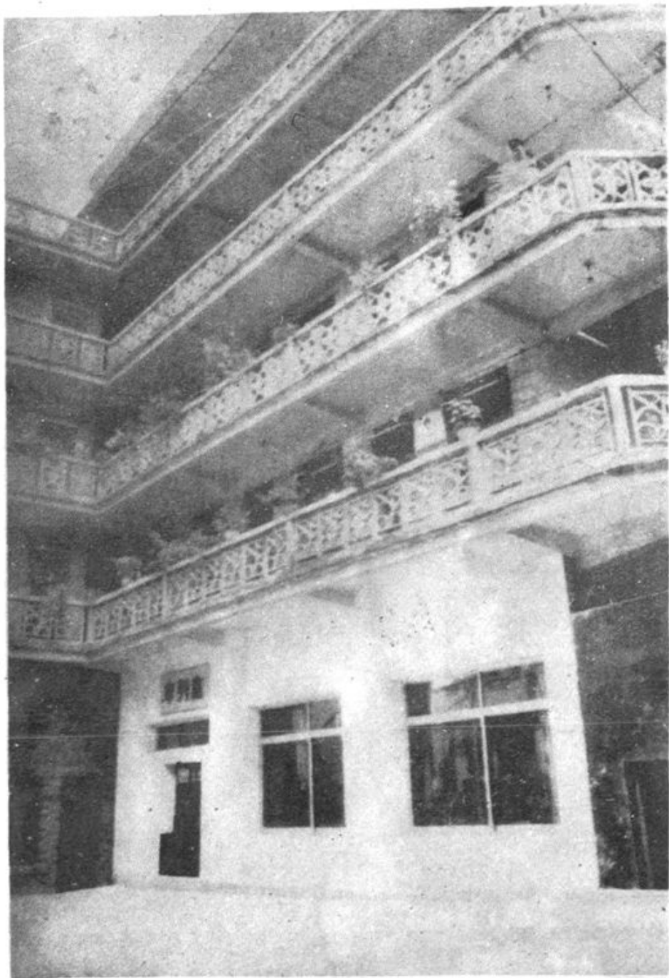
藤县人民法院办公楼
