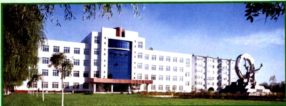
十三中学教学实验大楼
