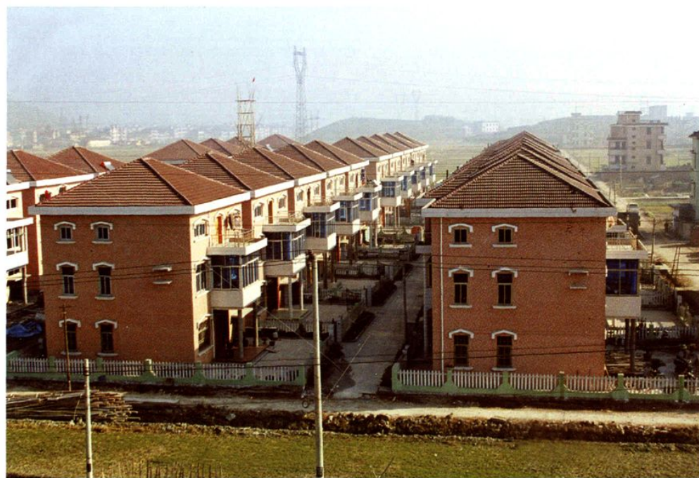
萧山平原区新农村(闻堰镇黄山村)
