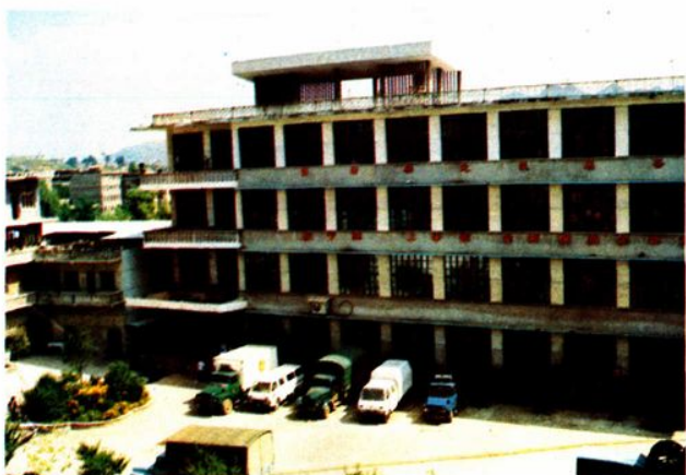
毕节地区邮电局电信综合大楼
