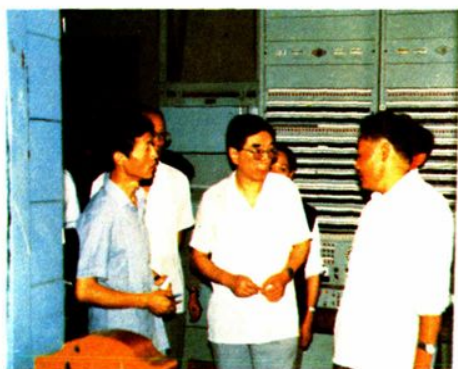
1990年8月邮电部副部长朱高峰（中） 视察毕节地区邮电局长途电信机械设备。
