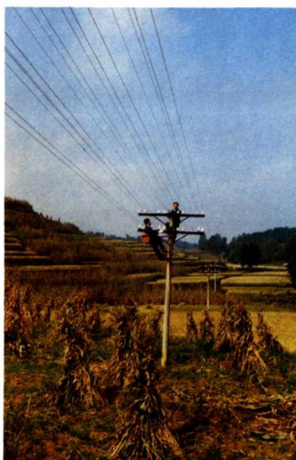
毕节长途电信线务站线务员检修杆线。
