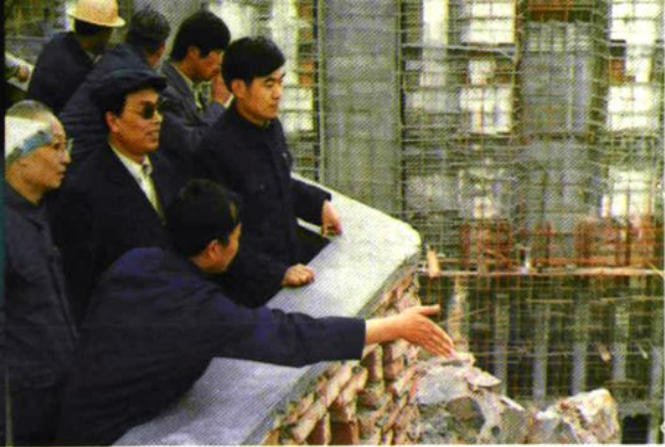
省建设银行领导在龙羊峡水电站工地了解工程建设情况
