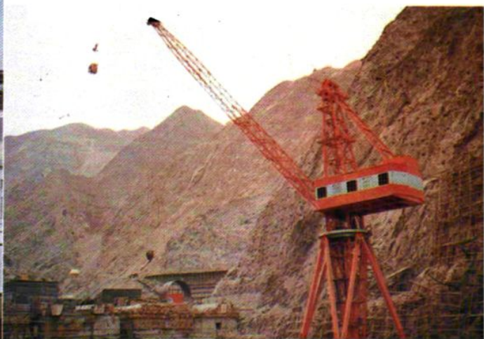
李家峡水电站正在加紧建设
